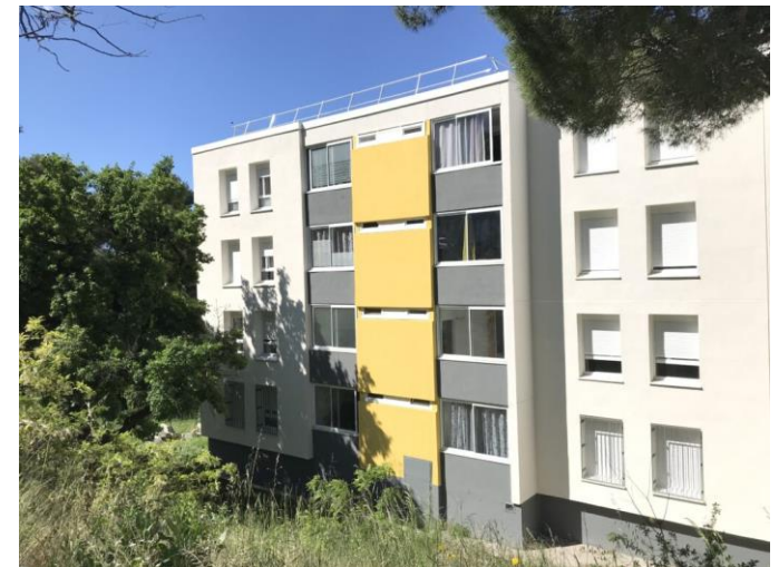
Les rénovations en site occupé et à budget se concentrent généralement sur l'amélioration de l'enveloppe sans excès de matériaux ajoutés. Ici l'exemple du projet Gavotte.
