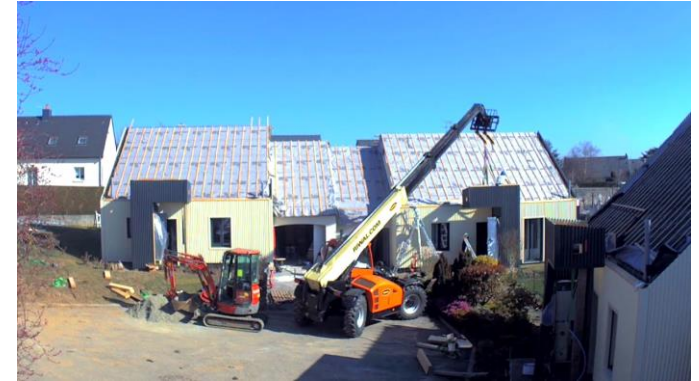
Le dispositif d'isolation extérieure « énergiesprong » pour le logement individuel représente une opportunité de réduire les émissions liées à l'énergie de chauffage.
