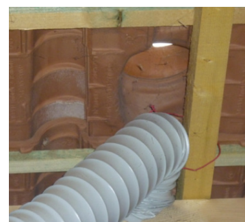
Figure 4. Réseau d'extraction non raccordé et sortie d'air obstruée Maison n°18
