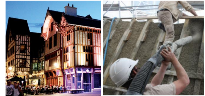
Rénovation de la maison du tourisme de Troyes (10), XVI e siècle. Le béton de chanvre utilisé pour le remplissage des pans de bois (30cm) et l'isolation de la toiture présentent à la fois un intérêt patrimonial et hygrothermique. Une opération s'appuyant sur les savoir-faire locaux, reproductible pour la rénovation du bâti ancien du centre-ville de Troyes.
