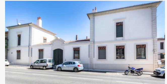
1 er Bâtiment Patrimonial à Energie Positive et Bas Carbone 100% autonome en énergie (sans isoler les murs)
