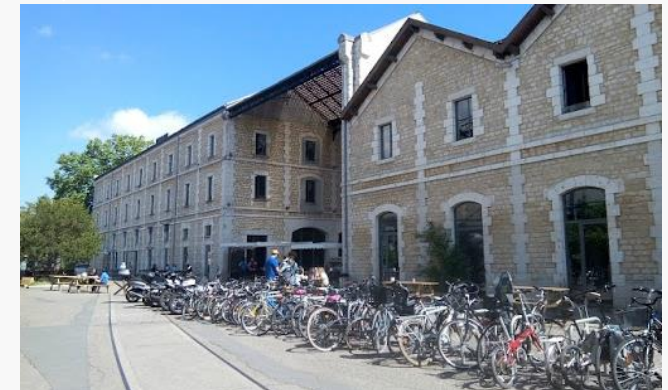
5 SERVICES LIÉS À LA MOBILITÉ DOUCE - L'écosystème Darwin à Bordeaux dans la caserne Niel constitue un exemple d'intégration de services bas-carbone avec un atelier de réparation de vélo (l'étincelle), des concepts stores autour de la valorisation et du réemploi de la matière et une offre de restauration alimentaire bio.
