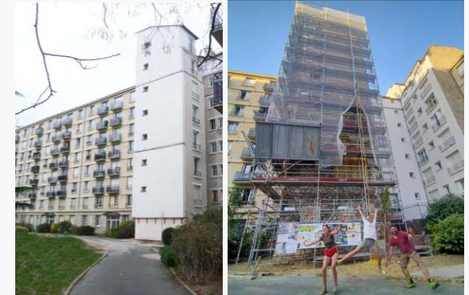
Images du pignon existant avant et après la mise en œuvre.
