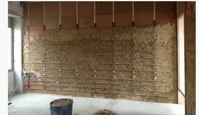
Mur chauffant « low-tech » réalisé en DUO TERRE (structure bois + isolée fibre de bois + enduit terre),
