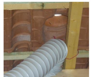
Figure 4. Réseau d'extraction non raccordé et sortie d'air obstruée Maison n°18
