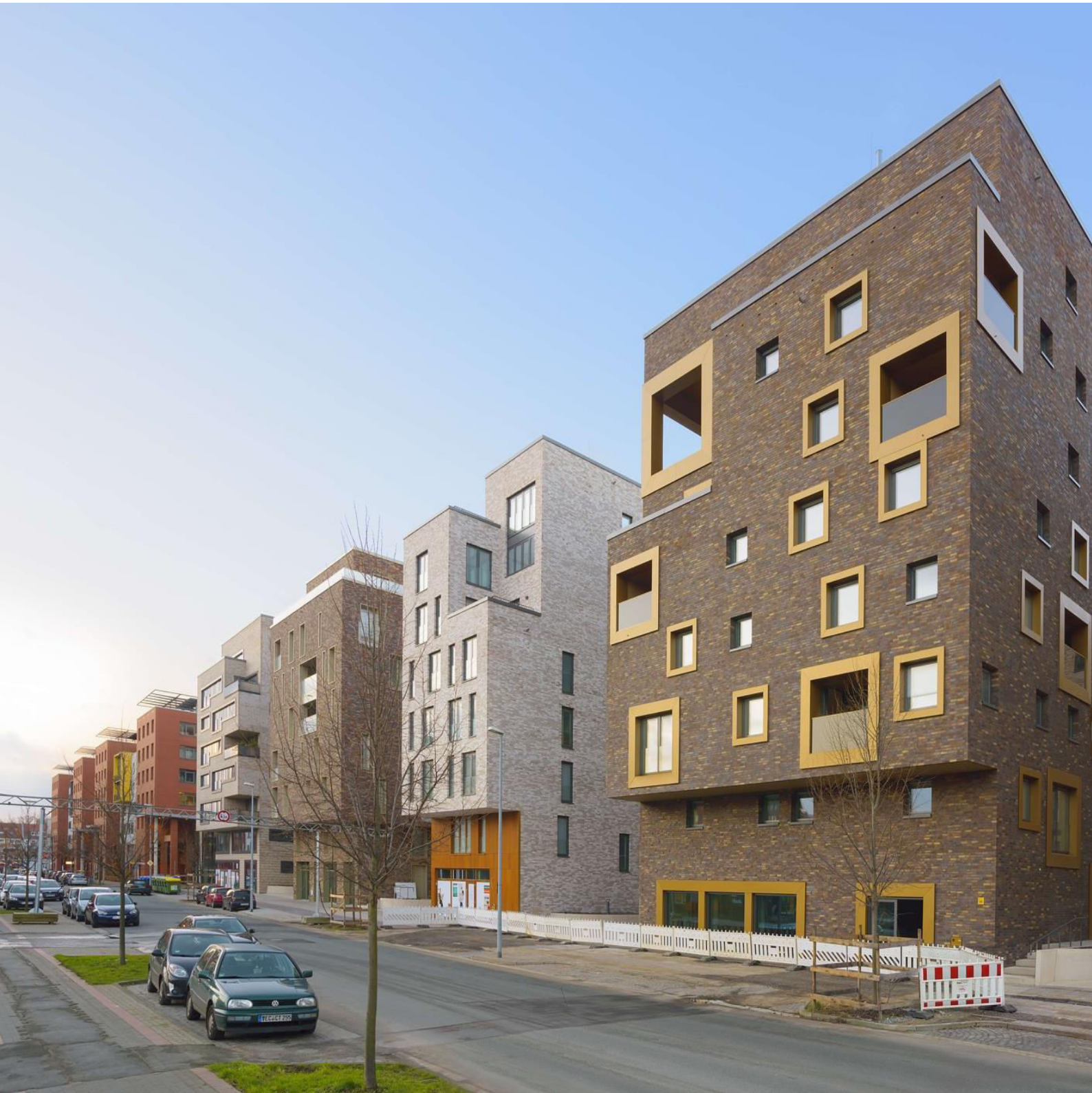
Figure 8 - Haus B1, Projekt VIER, Pelikanviertel, Hannover - DGNB Score 'Platinum' (Source: Gundlach GmbH & Co. KG, Photographer: Clemens Born)
