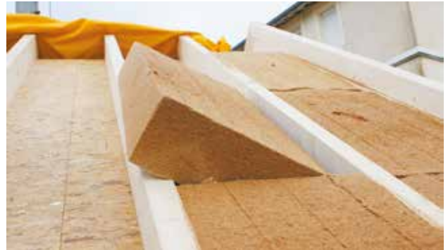
La laine de bois est utilisée dans la fabrication d'isolants pour le toit et les murs.
